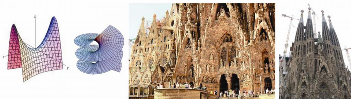
Рисунок 1. Собор Саграда де Фамилия и его конструктивное решение на примере гиперболического параболоида и геликоида
